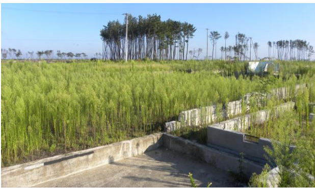
写真-2 基部を残し洗い流された住宅地，遠くに残存した防潮林の一部が見える
