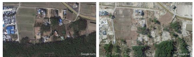
写真-7 残存する防潮林と流出を免れた家屋 (地点④)
