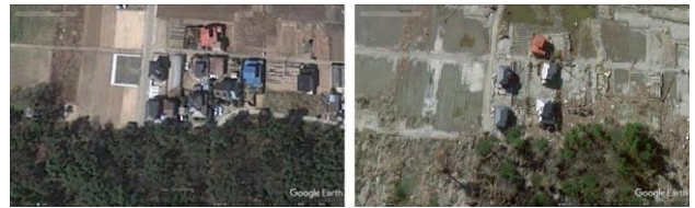
写真-5 津波後に残存した防潮林の一部と流出を免れた家屋の一部 (地点②)
