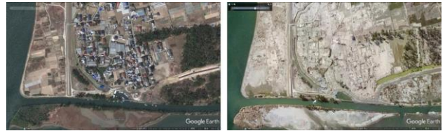
写真-4 防潮林がほとんど存在しない箇所の津波前後の様子 (地点①)
